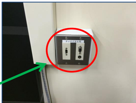
タッチパネル用入力端子盤 (アナログRGB・音声・HDMI)
